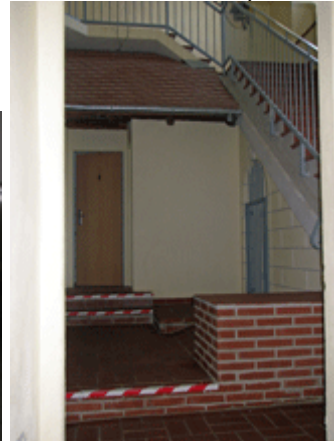
Der untere Sanitärbereich
